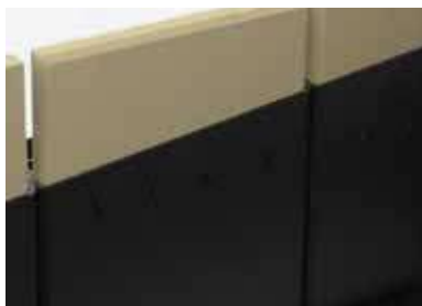
Refuerzo interior de acero y vermiculita.
